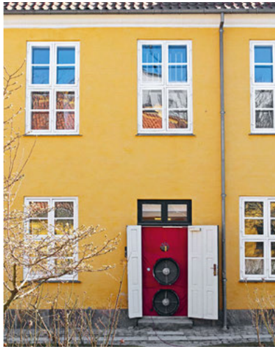
Fig. 4.5: Blower door test
