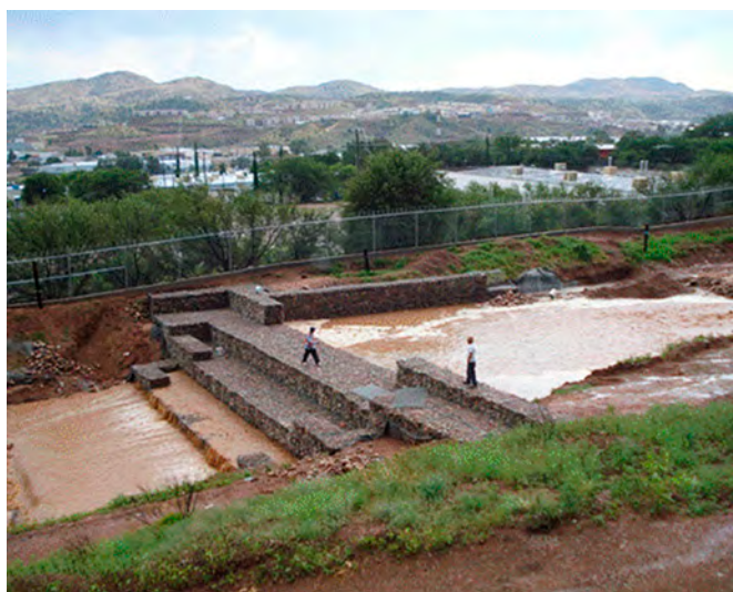
Nogales, Sonora, Detention Basin La Bellota.
