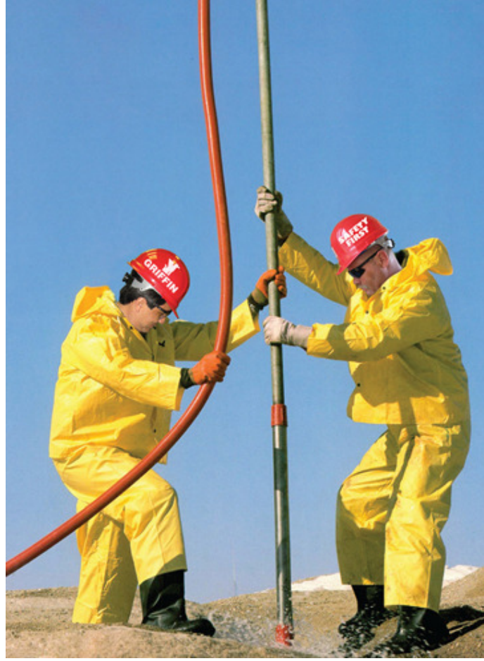
غرز الحربة بواسطة دفع المياه بقوة من طلمبة الغرز
