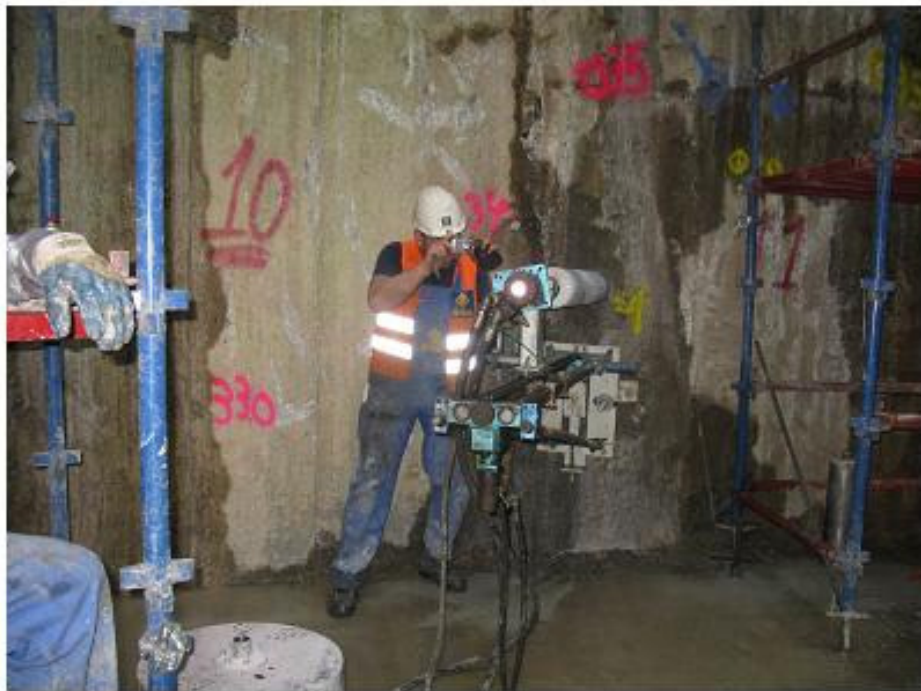
تنقيب الحائط الخرساني لحوائط الجبارة أو غرفة التوزيع
