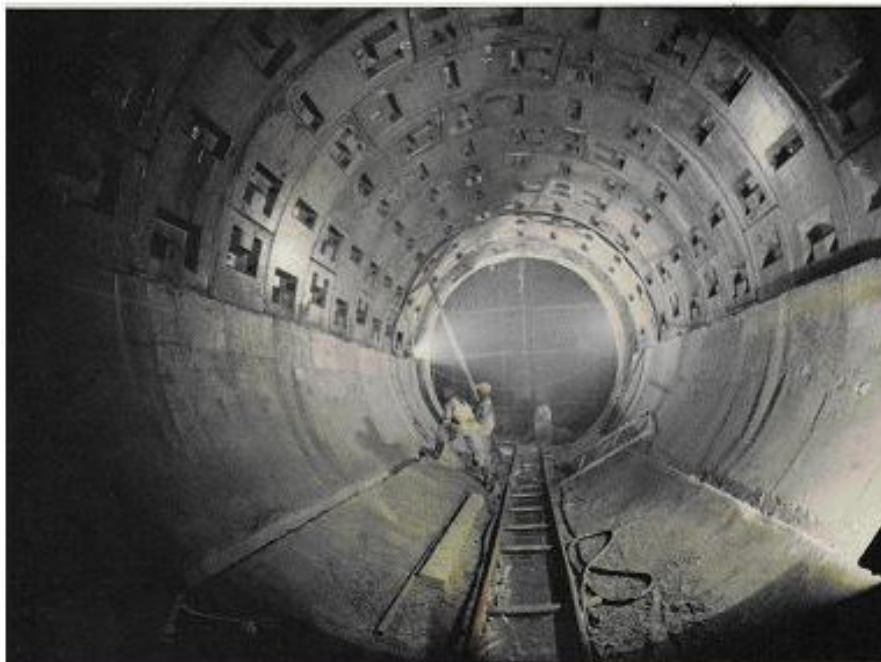
△ منظر للنفق قطر داخلي 5 م بعد حفره وتركيب قطع الخرسانة الدائرية وصب خرسانة الليل وهذا النفق رابط البهارة الصغيرة بالبهارة الكبيرة
