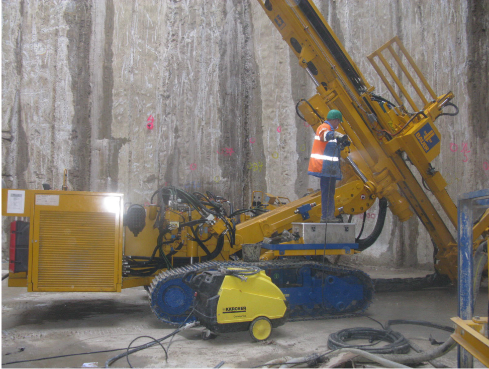
معدات تثقيب التربة ، ثقب التربة حتي ٢٥ متر عمق ووضع مواسير قطر ١٠ سم الخاصة بتجميد التربة
