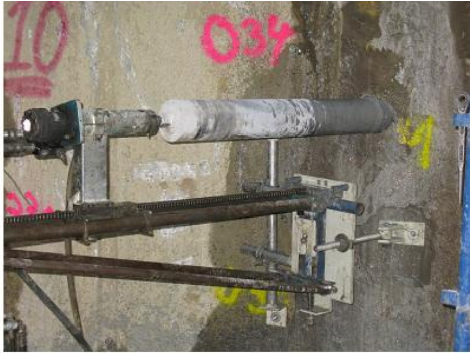
تنقيب الحائط الخرساني - شكل (٤٢) :
