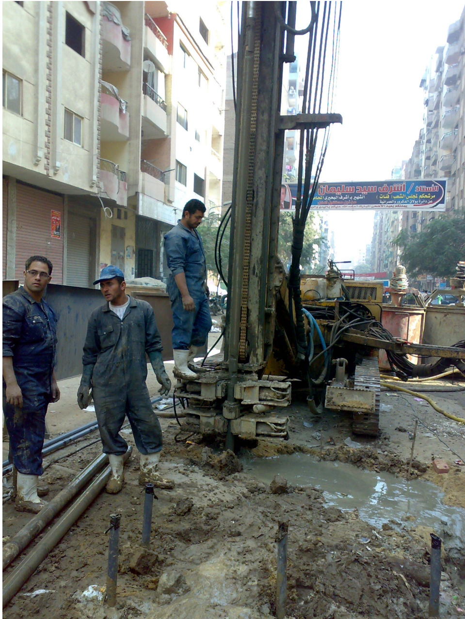
شكل (٣٣) معدات التنقيب و أنزال مواسير الحقن
