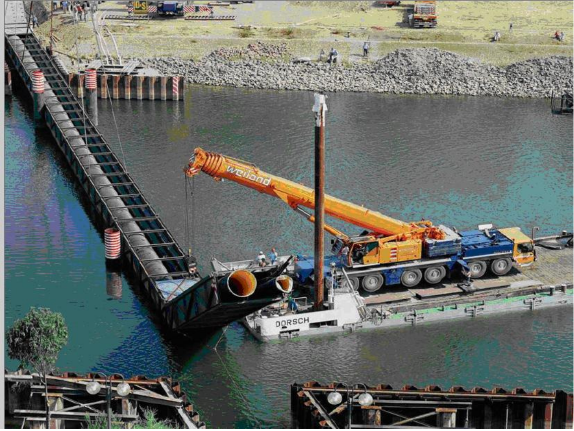
تعدية سيفون – تم استخدام مواسير بولي إيثيلين عالي الكثافة. تم تشكيل ولحام المواسير طبقا لقطاع النهر
