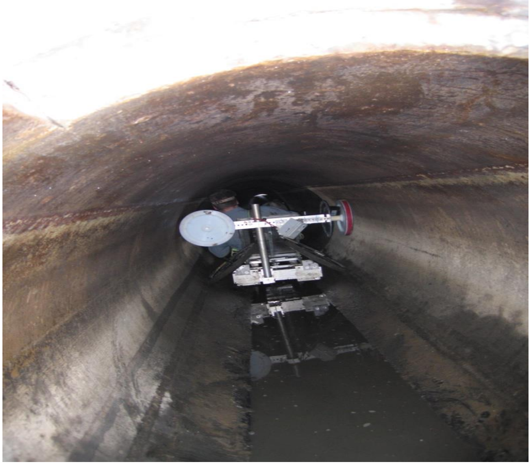
شكل يوضح عملية فحص الخط بواسطة الجهاز
