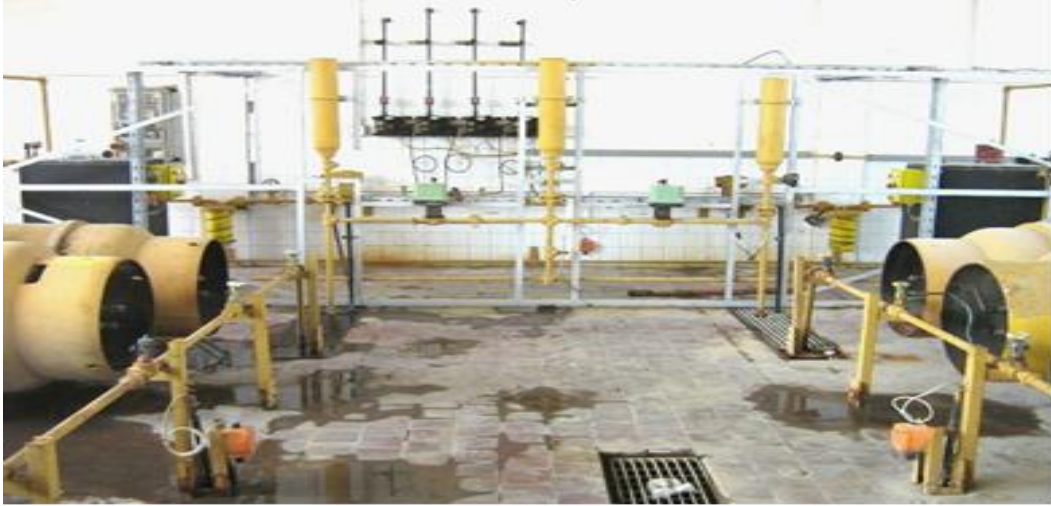
شكل (1) عنبر اسطوانات الكلور
