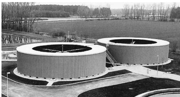
Fig. 7.2 Trickling filter, BIO-NET, Norddeutsche Seekabelwerke, Germany.
