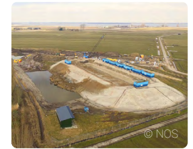
6 Eemdijk Test Site
