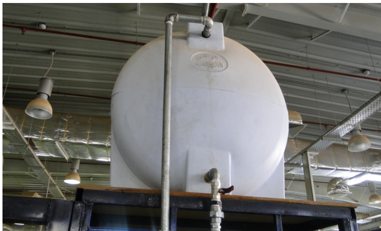
شكل يوضح خزان علوي لأغراض التدريب تتضح فيه الفتحات الخاصة بمثل هذا النوع من الخزانات .
