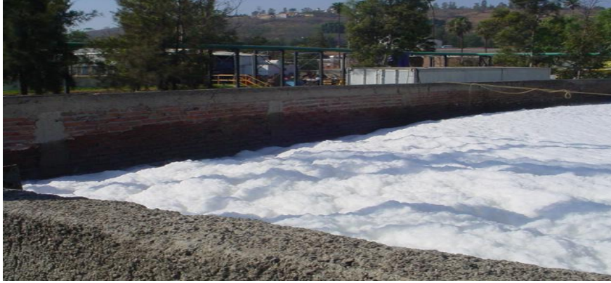
شكل رقم (5-1) وجود رغاوى بيضاء بأحواض التهويه في بدايه التشغيل
