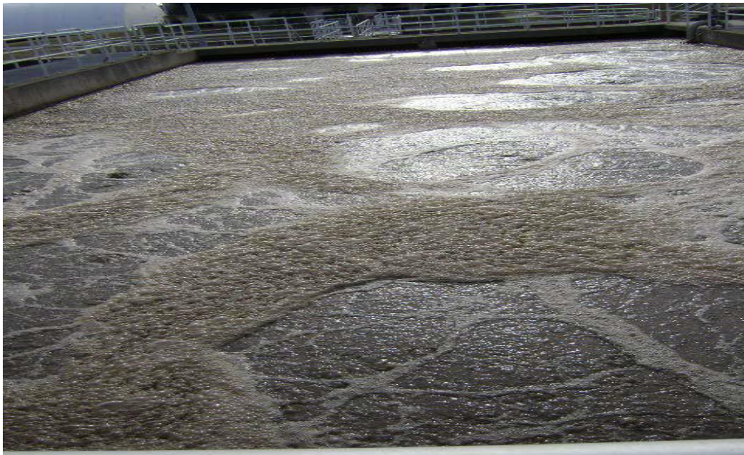
شكل رقم (5-6) وجود رغاوى سمراء بحوض التهويه
