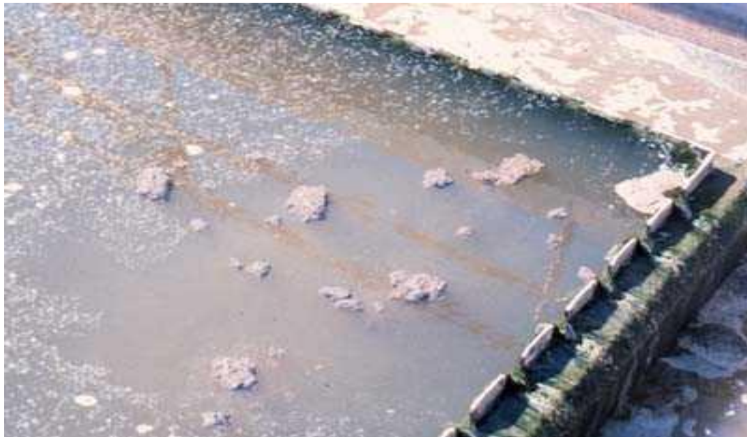
شكل رقم (٥-٧) وجود فقاعات غاز النيتروجين بالحمأه وطفوها على السطح
