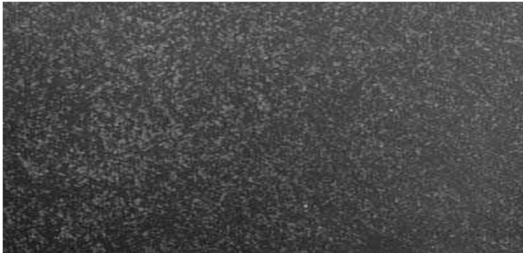
شكل رقم ( ٥-١٢ ) طفو حمأة ناعمة وانتشارها وتكوين طبقة علسطح أحواض الترسيب النهائى
