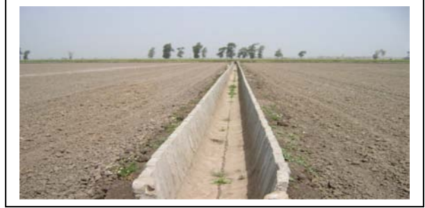
الشكل رقم (٦) مروى من الطوب الأبيض - مع وجود الطوب الأبيض في القاعدة على طبقة من الرمل
