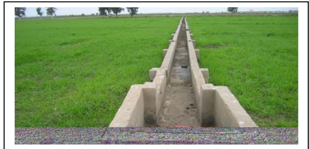
الشكل رقم (٧) مروى من الطوب الأبيض ذو قاعدة خرسانية عادية
