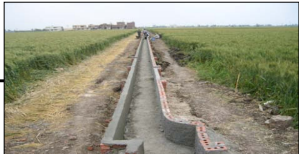
الشكل رقم (٨) مروى نصف طوبة على قاعدة مبنية بالطوب على طبقة رملية
