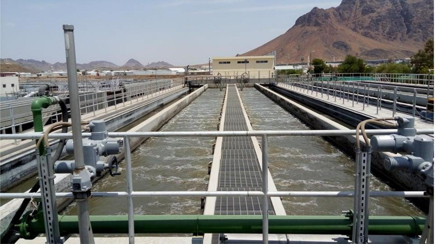
زمن الحجز الهيدروليكي للأحواض 20min. بالنسبة لغرفة الرمال والحصى يوجد أربعة أحواض عمقها 3.5m عرضها 3.35m وطولها 50m حجمها  $521 \text{ m}^3$  ؛ أما غرفة الشحوم وهي 4 غرف عرضها الغرفة 1.68 m وطولها 50 m
