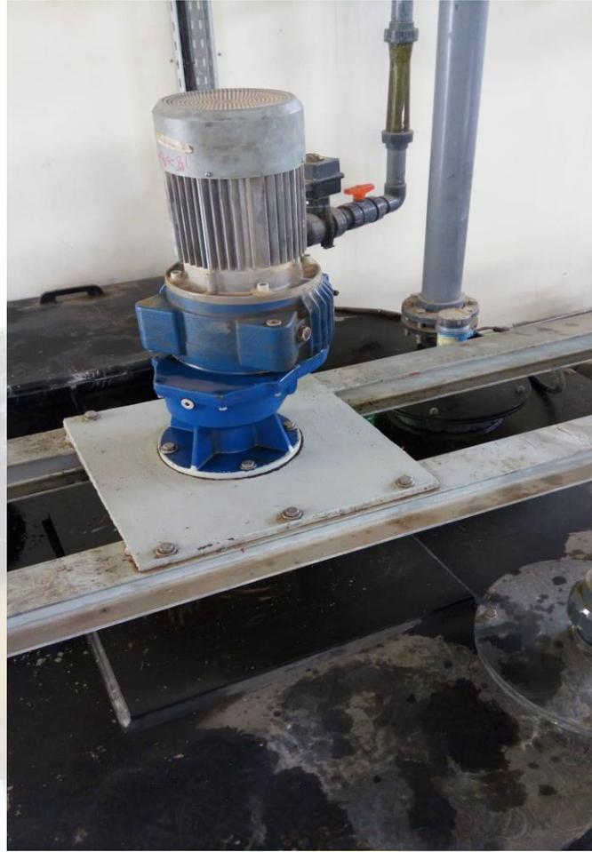
تستخدم الوحدة في حال فشل نظام التطهير بالأشعة فوق البنفسجية بشكل إحتياطي للتطهير ويكون متوسط حقن الكلور السائل يكون عادة بين 4-5 ppm للمياه المعالجة وتختلف الجرعة باختلاف جودة المياه المعالجة ثانياً .
