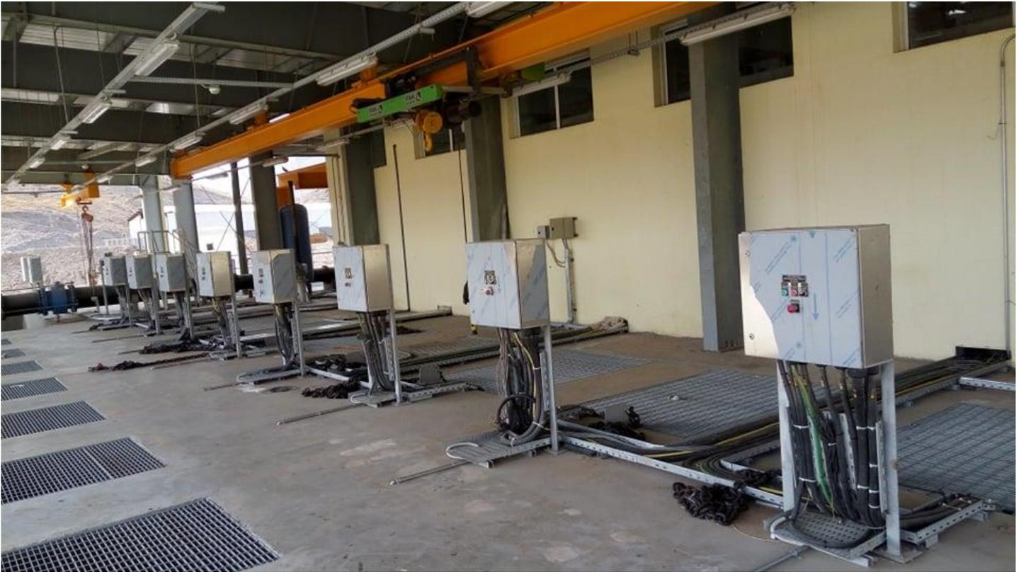
تم تزويد المحطة بعدد 8 مضخات لرفع المياه المعالجة بعد تطهيرها لإستخدام الزراعي والفائض إلى الوادي كما تم تزويد المحطة بمحطة لرفع المياه الناتجة من الغسيل العكسي عدد 2 مضخة غاطسة للمرشحات ومحطة الخدمة بعدد 3 مضخات ومضخات لتزويد وحدة تجريع الكلور وعددها 3 مضخات
