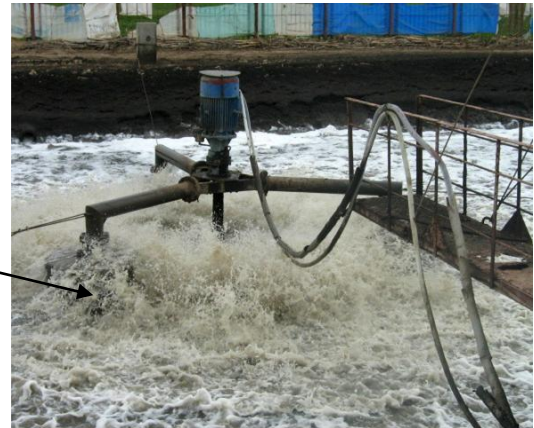
صورة رقم (14) الهوايات المستخدمة في تهوية برك الأكسدة الموهوة
