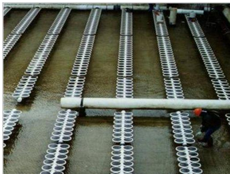
صورة رقم (10) ناشرات الهواء بحوض التهوية
