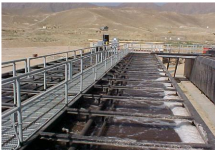
صورة رقم (10) ناشرات الهواء بحوض التهوية
