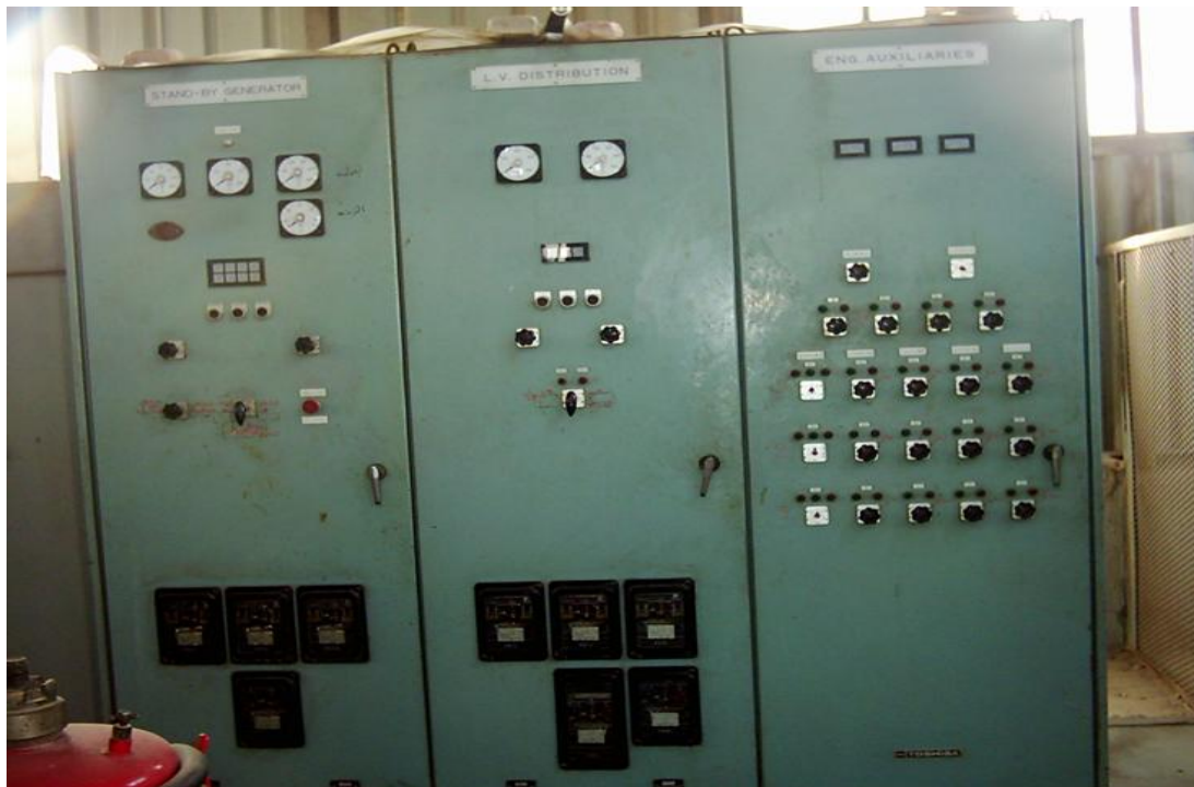
لوحة جهد منخفض تتغذى من مولد وتوزع التيار إلى الأقسام المختلفة
