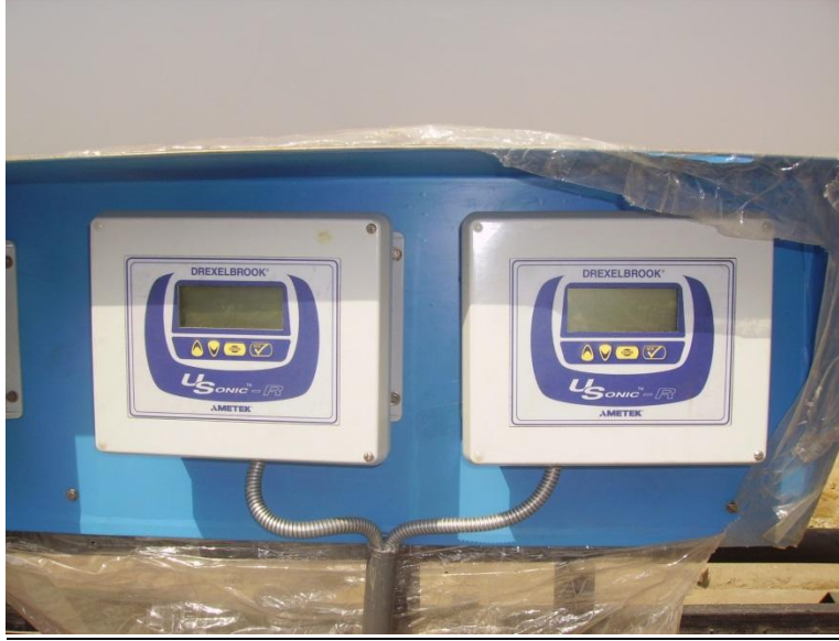
شكل (٥) جهاز الترانسيمتر (الوحدة الحسابية) لقياس التدفق بالموجات فوق الصوتية
