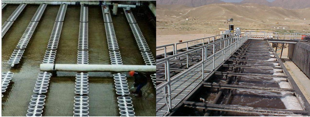
صورة رقم (١٠) ناشرات الهواء بحوض التهوية
