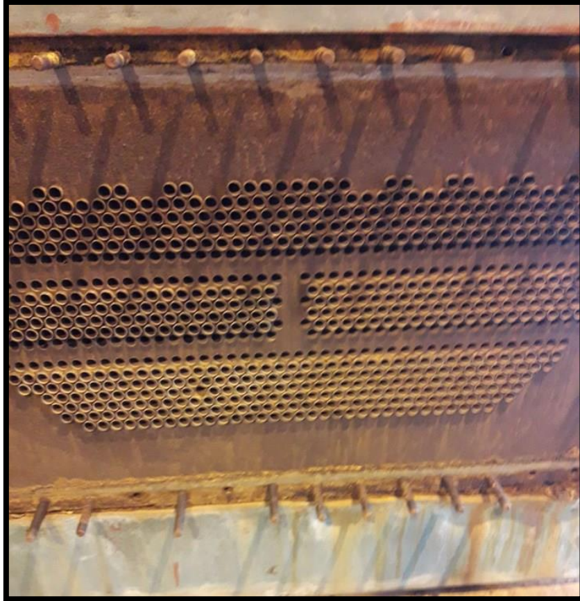
وهذه صورة الكوندينسر الذي يمر من خلاله مياه برج التبريد في الدورة المفتوحة:
