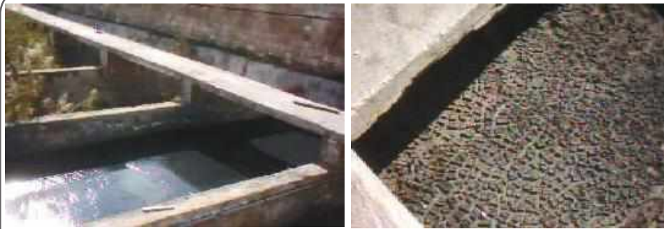
الشكل (18-1-2-7-1) أحواض تجفيف الحمأة الرملية في مصبغة اقمشة ( حلب - السورية للغزل )
