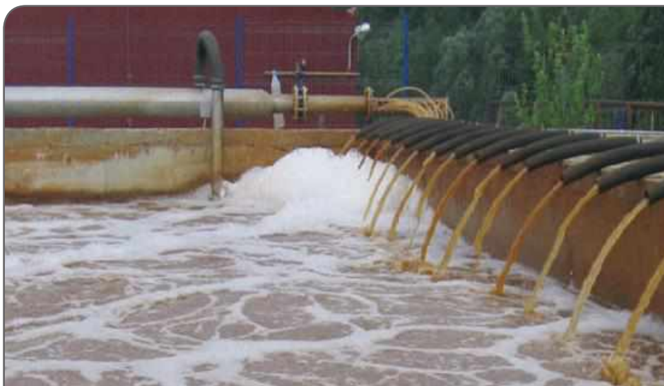
الشكل (1-2-1-5-30) يبين حوض التهوية ومضخات الحمأة الراجعة لمحطة المشروبات في رومانيا
