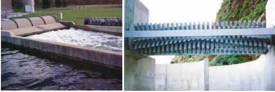
الشكل (3-10-11) صورة لفرشاة من صفائح الكروم مركبة في قنوات الأكسدة
