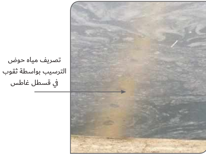
الشكل (5-1-6-9) سحب الماء المُرسب عن طريق أنابيب مثقبة تحت منسوب الماء
