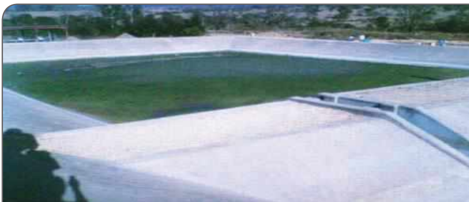
الشكل (1-8-2-1-18) بحيرة تجفيف الحمأة (من Batseta)
