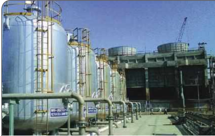
الشكل (1-3-6-29) c : المرشحات الرملية ISTP Jamnagar, India
