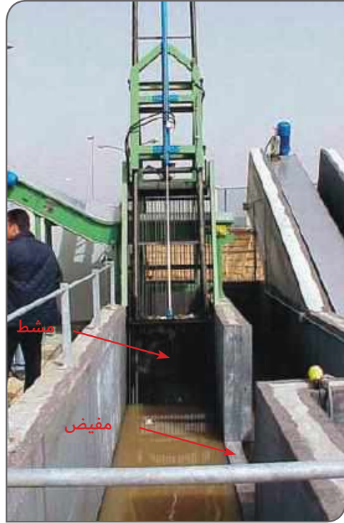
الشكل (3-2-4) مصفاة ذات قضبان خشنة شاقوليه آلية
