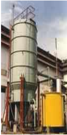
الشكل (2-1-2-17) مرشح عميق (c)، انتراسيت تدفق للأسفل - d، رملي تدفق للأعلى
