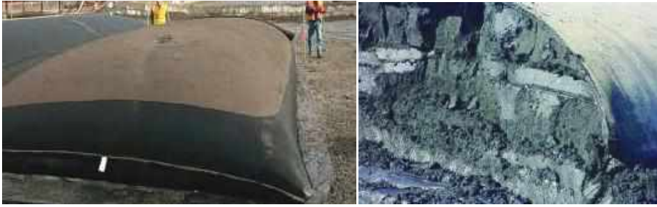
الشكل (1-6-2-1-18) نزع مياه الحمأة بالجيوتيوب geotube (من TenCate™)
