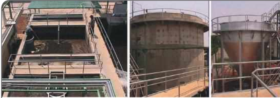
الشكل (3-2-2-3-4-19) من اليسار: حوض التوازن وحوض الترسيب الأولي - المفاعل اللاهوائي - المرسب النهائي المعدني [30]
