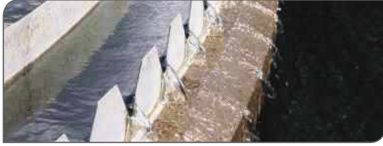
الشكل (4-1-6-9) هدار خروج الماء بشكل ٧
