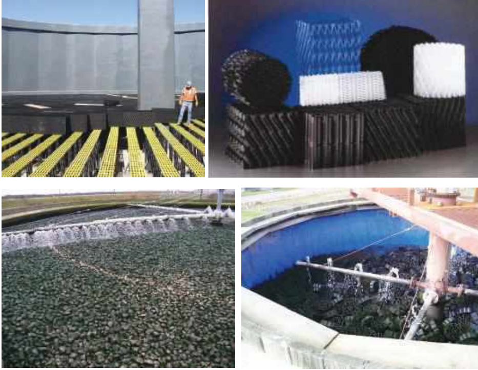
الشكل (1-2-3-14) بعض نماذج الميديا (حوامل الغشاء البيولوجي) المستعملة في المرشحات
