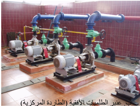
شكل رقم (٧-٨) طلمبة الأعماق التربينية والطلمبات الأفقية بعمليات الآبار
