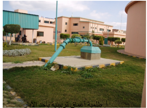
شكل رقم (٧-٨) طلمبة الأعماق التربينية والطلمبات الأفقية بعمليات الآبار
