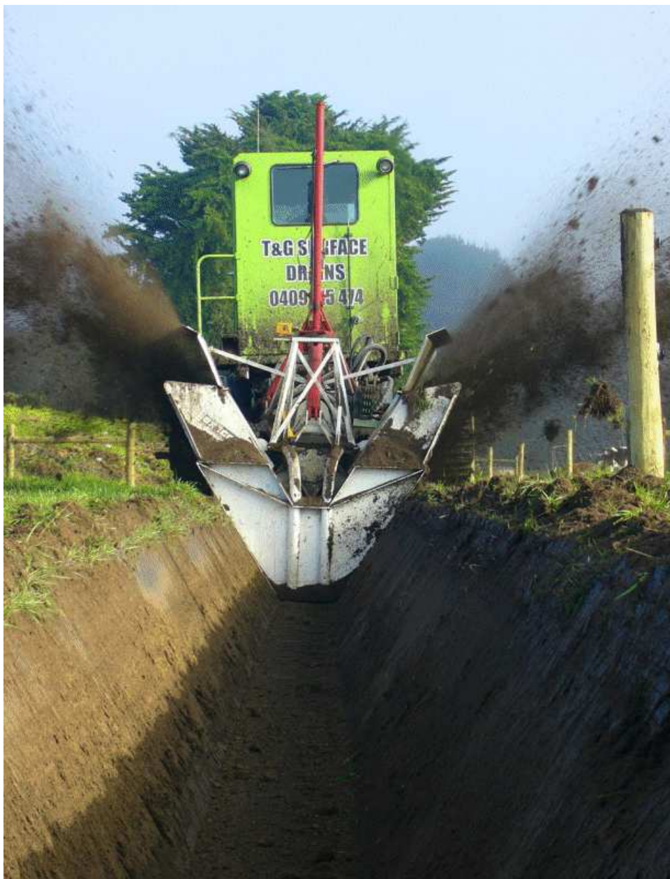
شكل (٣-٤) ماكينة إنشاء المصارف المكشوفة أثناء العمل
