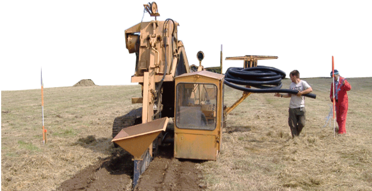
شكل (٦-٤ ب) ماكينة حفر وتركيب المصارف المغطاة
