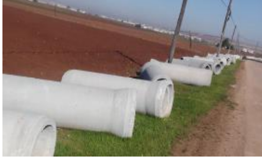
الشكل (5-11) توضع الأنابيب بجانب الخندق المحفور
