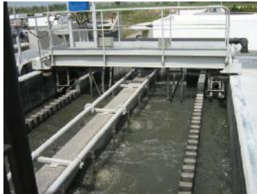
مستوي المياه بالمدخل
