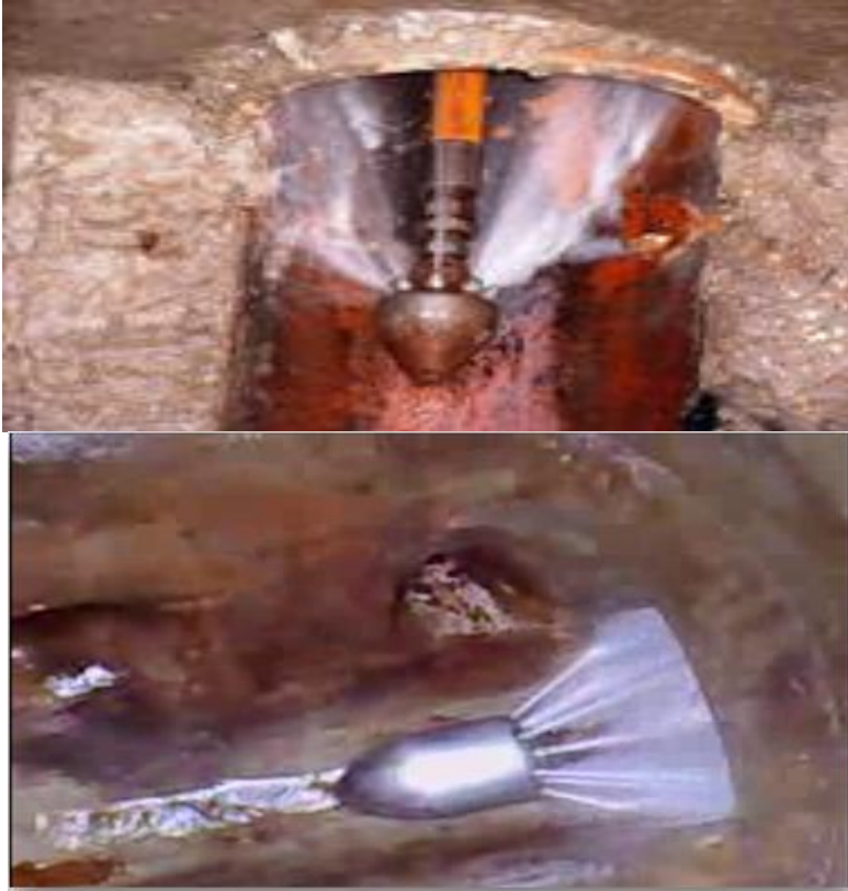
الشكل (9-23) تقدم النصلة ضمن الأنبوب
