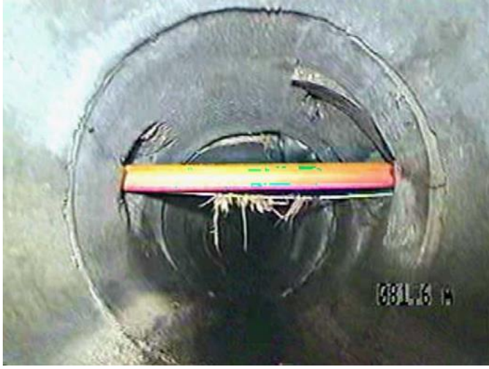
شكل (2-9) اختراق الأنبوب من أنبوب شبكة أخرى بشكل غير فني
