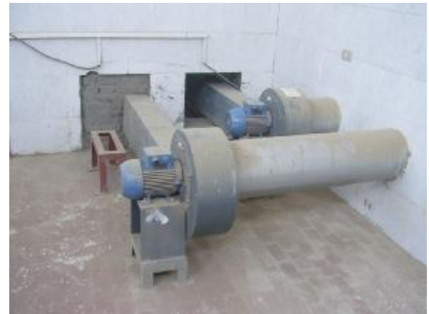
الشكل رقم (١٢ - ٣١) بلاورات هواء لسحب غاز الكلور المتسرب وظلمبات الصودا
