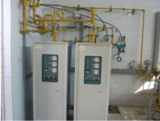
الشكل رقم (١٢ - ٢٩) اسطوانات الكلور وجهاز حقن الكلور (الكلورينيتور)
