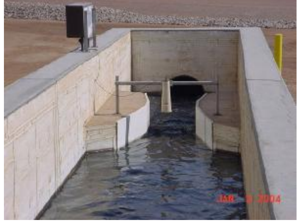
شكل رقم (١١-٤٣) قناة بارشال لقياس التدفق
