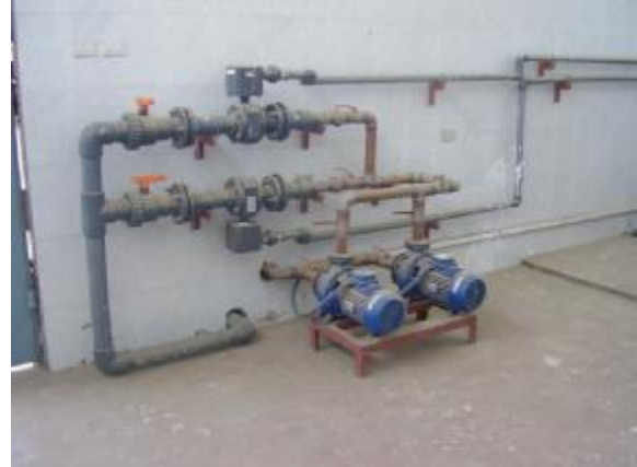
الشكل رقم (١٢ - ٣٠) ظلمبات البوستر وأحواض تلامس الكلور
