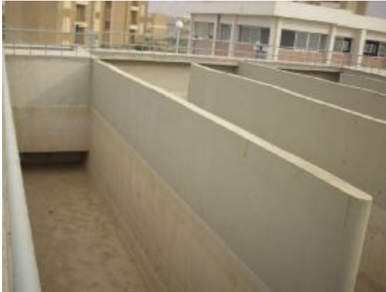
الشكل رقم (١٢ - ٣٠) ظلمبات البوستر وأحواض تلامس الكلور
