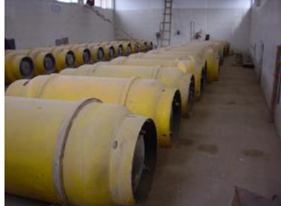
الشكل رقم (١٢ - ٢٩) اسطوانات الكلور وجهاز حقن الكلور (الكلورينيتور)
