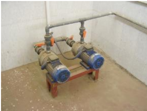
الشكل رقم (١٢ - ٣١) بلاورات هواء لسحب غاز الكلور المتسرب وظلمبات الصودا
