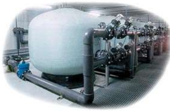
شكل ( 7 ) فلاتر رملية لفصل الشوائب الدقيقة الصلبة في مرحلة المعالجة الأولية
