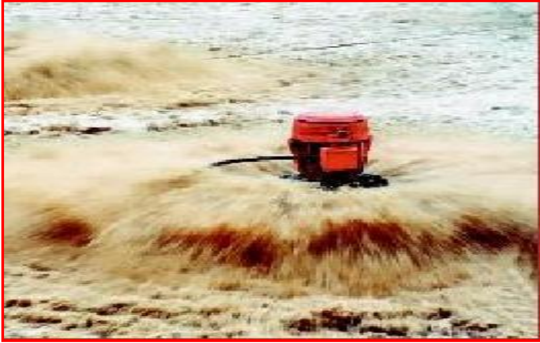
صورة رقم ١٤ توضح مراوح تقليب المياه في أحواض التهوية
