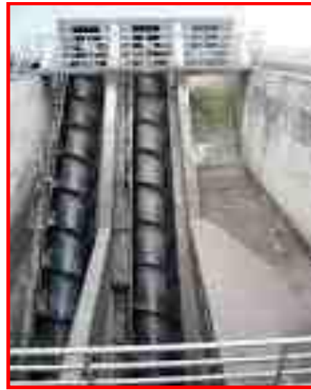
صورة رقم ٥ توضح طلمبات حلزونية
