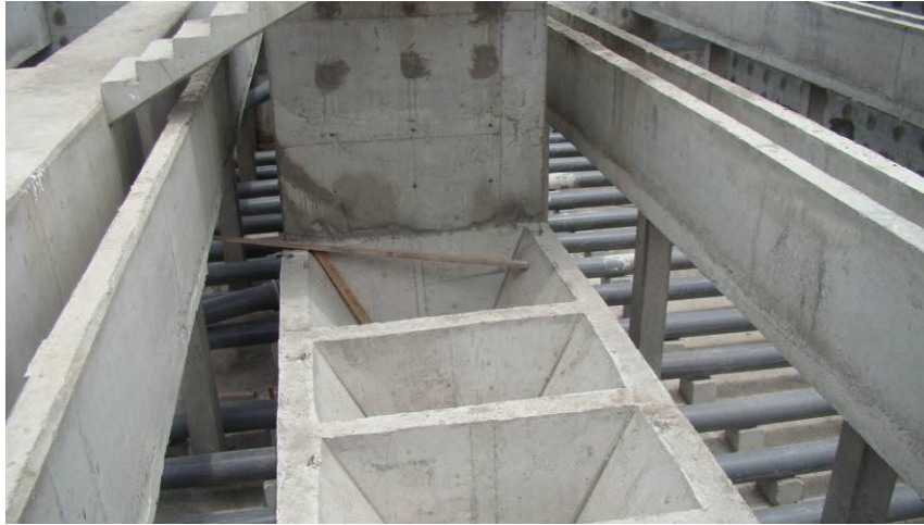
المروق اثناء الانشاء ١
