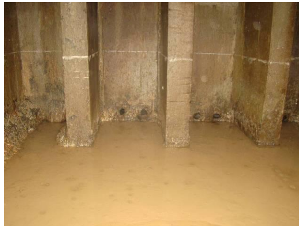
نظام توزيع مياه الغسيل و خروج المرشحة 1
