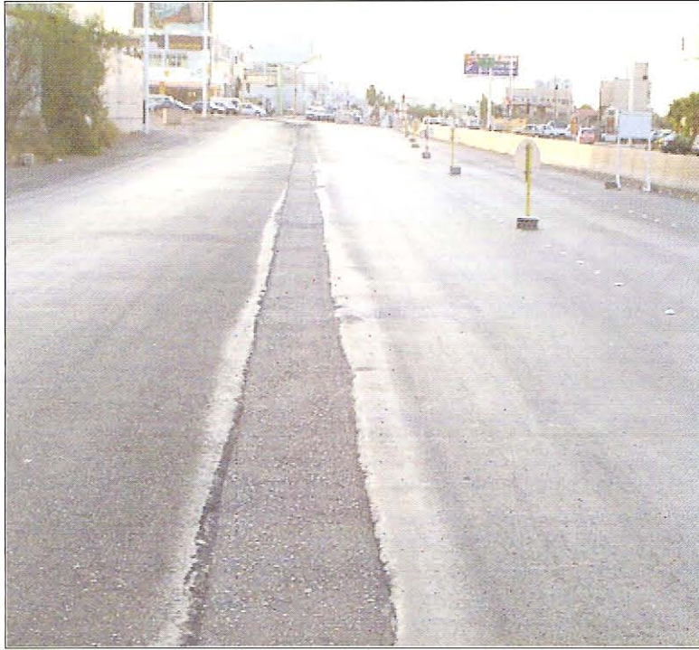
الشكل رقم ٤-١ : تآكل وتطاير
