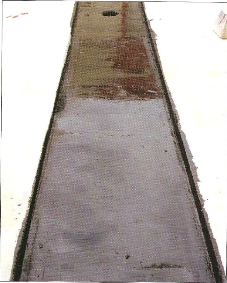
الشكل رقم ٦-٤ حالة رسوب لرش مواد التشريب الأسفلتي - زيادة في معدل الرش
