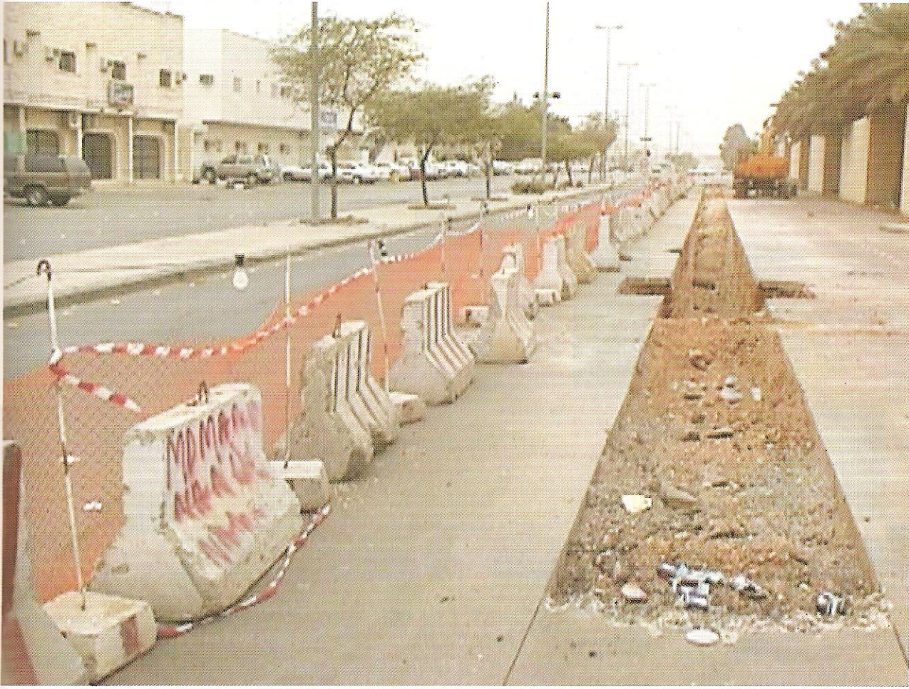
الشكل رقم ٣-٤ عزل منطقة العمل عن حركة السير
