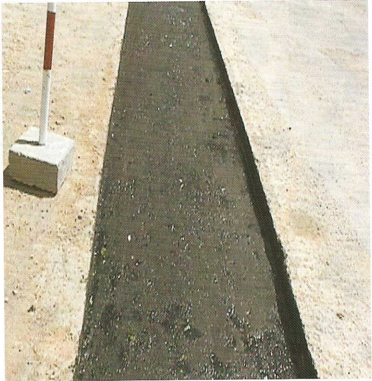
الشكل رقم ٥-١١ رش مادة التشرب اللاصقة
