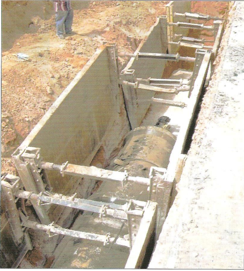
الشكل رقم ٥-٦ تدعيم جوانب الحفيرة
