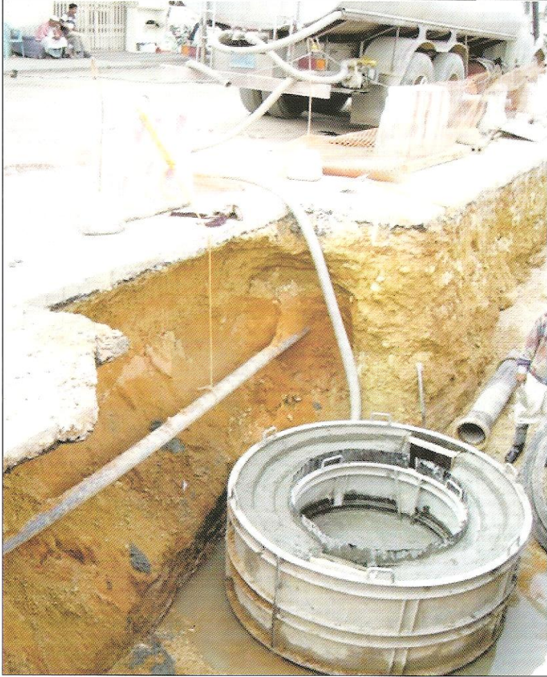
الشكل رقم ٧-٥ سحب المياه من الحفرية بالمضخة
