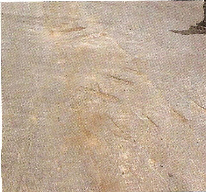
الشكل رقم ٦-٥ حالة رسوب الأعمال الأسفلتية- آثار لمعدات الحفر
