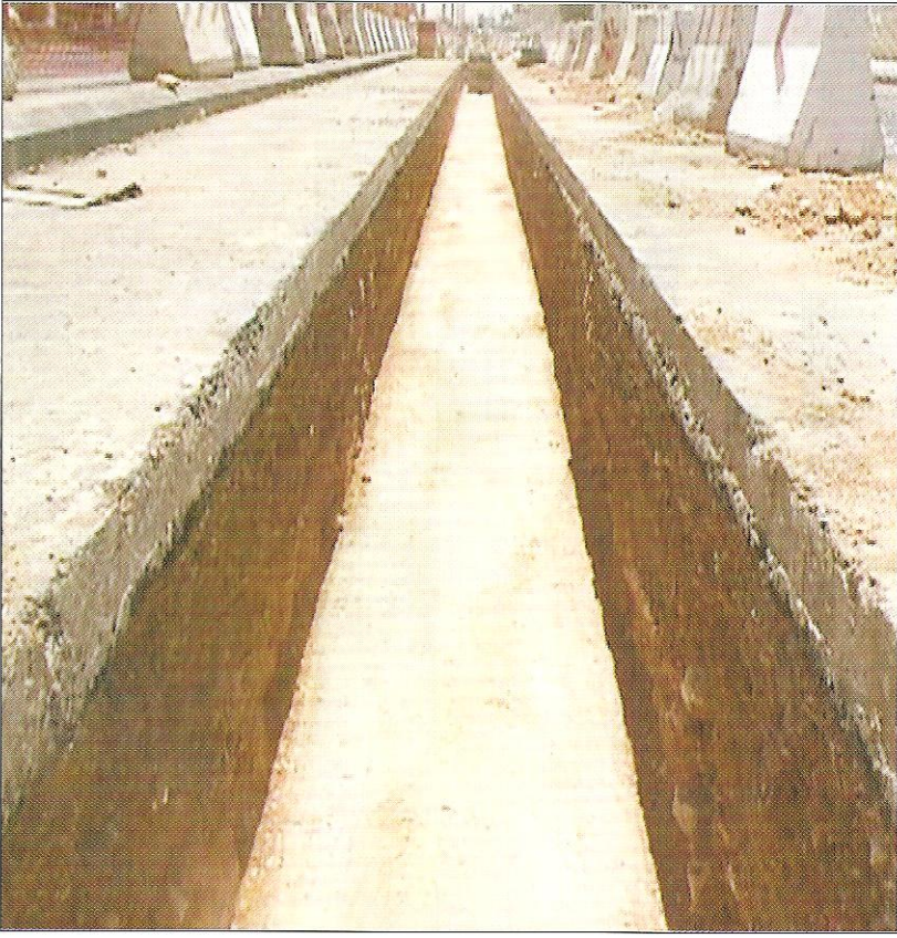
الشكل رقم ٨-٥ استواء وتجانس سطح طبقة مدكوكة
