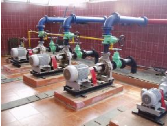
ب. عنبر الطلمبات الأفقية (الطاردة المركزية)
