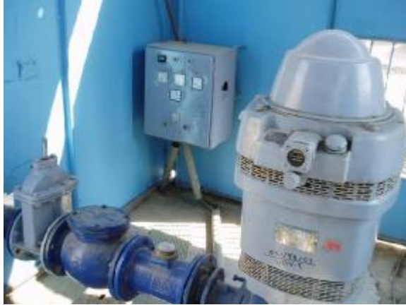
شكل رقم (٨-٢٥) محرك طلمبة الأعماق وخط الطرد
