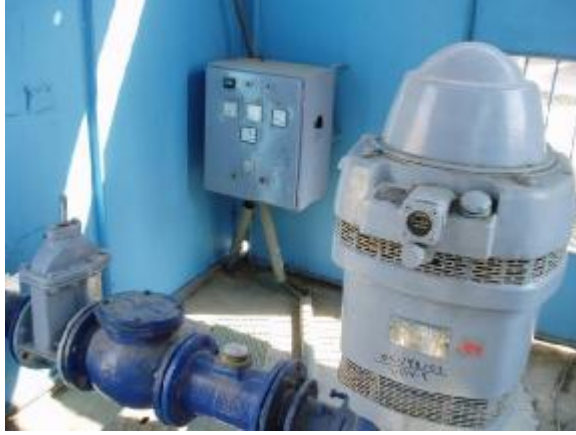
شكل رقم (١٠-١٨) محرك ظلمبة الأعماق وخط الطرد
