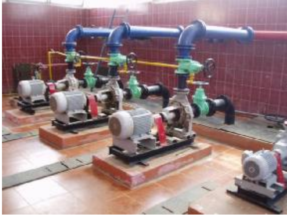
ب. عنبر الطلمبات الأفقية (الطاردة المركزية)
