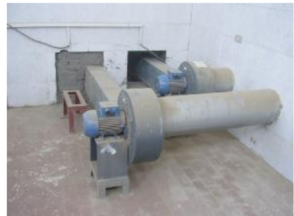
صورة رقم (١٢-١٤) بلاورات هواء لسحب غاز الكلور المتسرب وظلمبات
