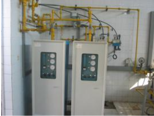
صورة رقم (٩-١٤) جهاز حقن الكلور (الكلورينيتور)
