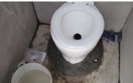
A fully constructed pour flush toilet
