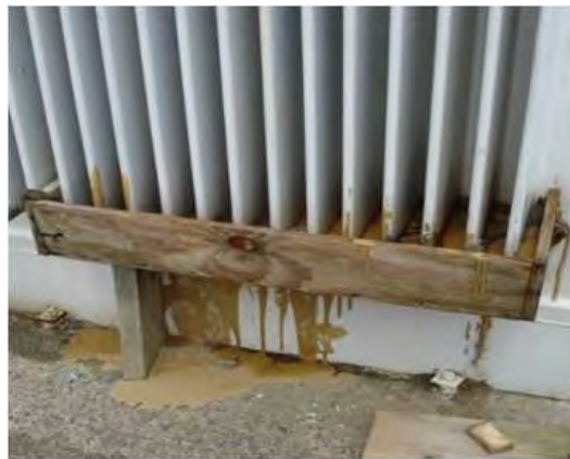
شكل 3-5 تسرب الزيت
