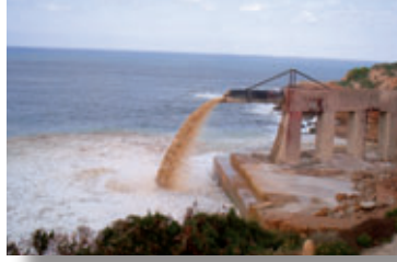
طرح نفايات أحد المصانع في الجرف الأصفر (أزمور، المغرب) مباشرة في مياه البحر
