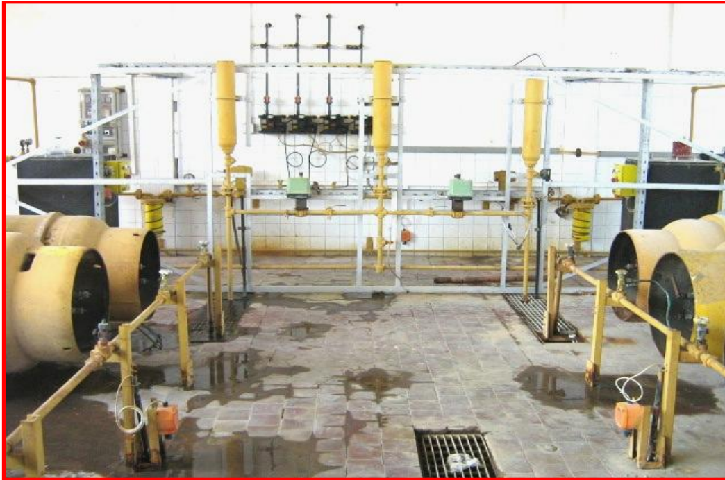
صورة رقم (1-6) عنبر اسطوانات الكلور
