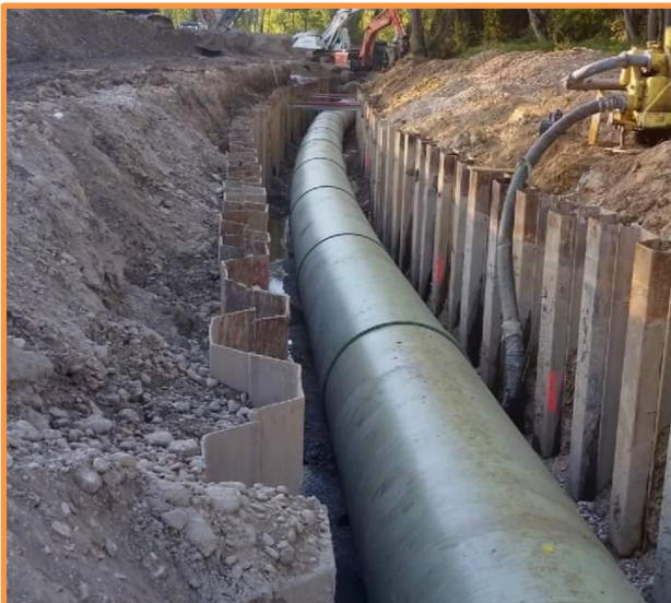
وصلة المواسير الفيرجلاس (GRP) باستخدام الجيوبولت الزهر
