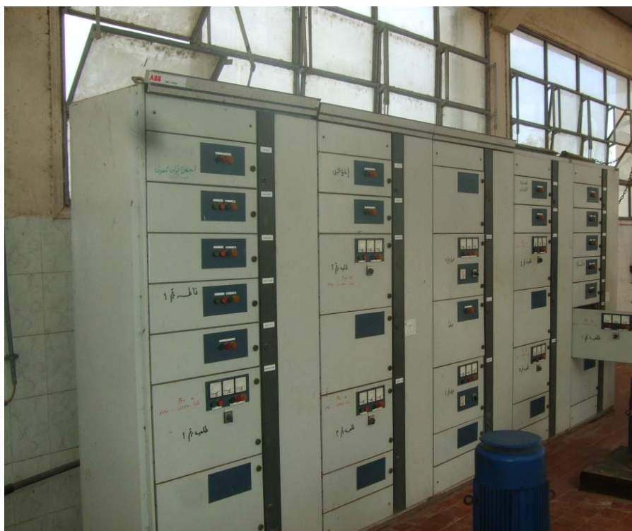
لوحة توزيع مبنى المياه العكرة
