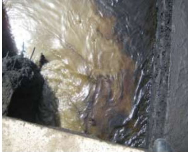
شكل يوضح خزانات الزيت المفصول
