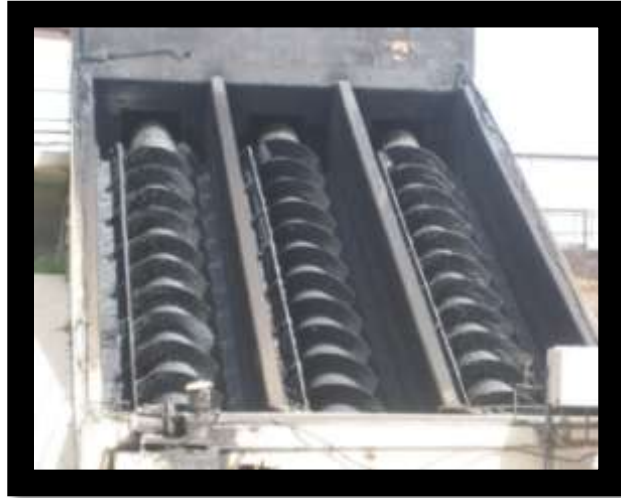
شكل يوضح المضخات الحلزونية
