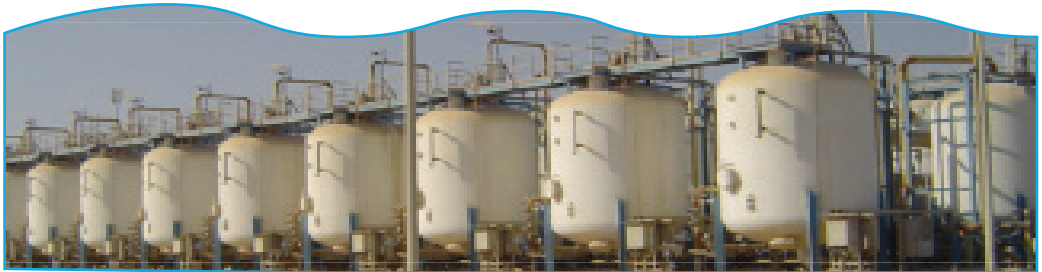
وحدات معالجة ( فلاتر الحجر الجيري ) - راس أبو فنطاس - دولة قطر
