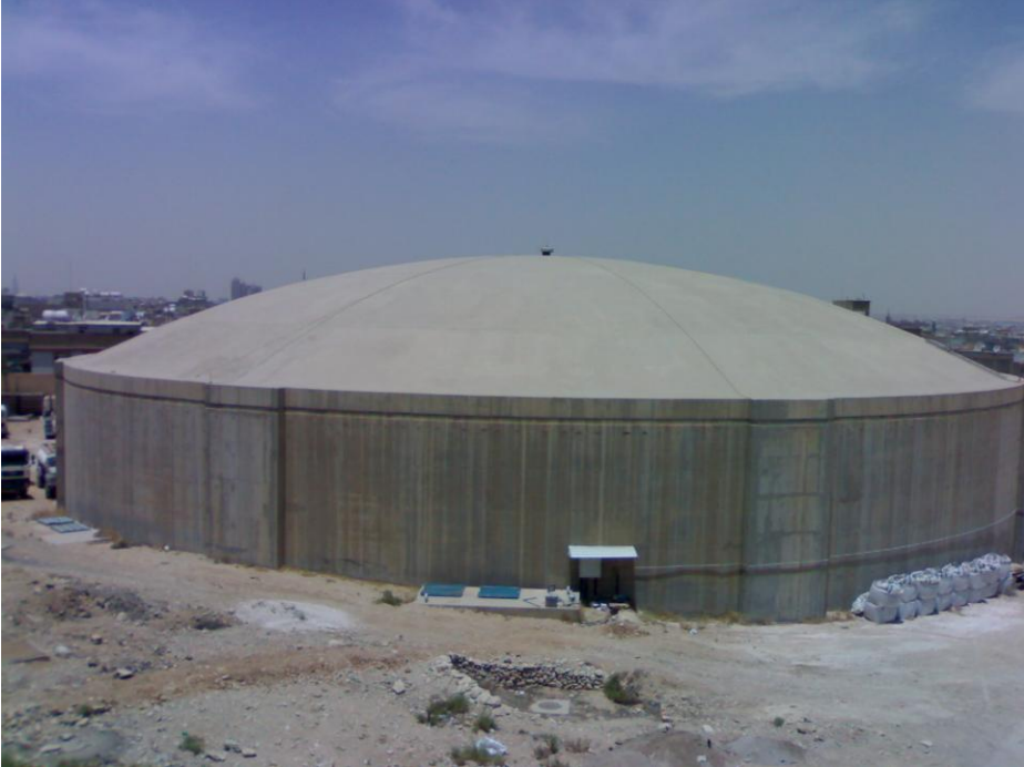
الخزان الرئيسي لتجميع المياه الناتج وموازنة الضخ في الشبكة
