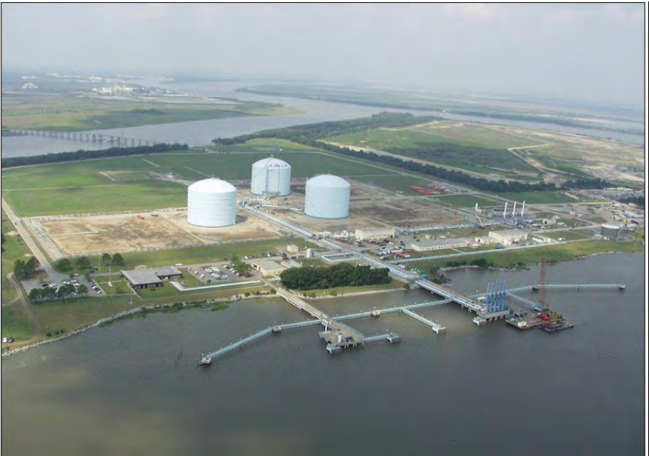
Cove point LNG terminal
