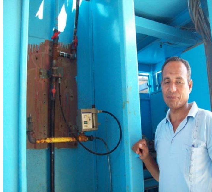
جهاز حقن الكلور - وجيفار الحقن
