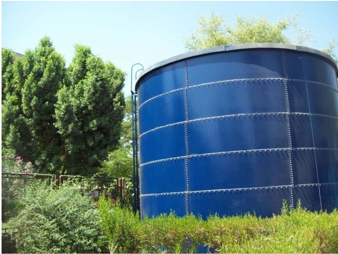
السلم الحديدي المجهز للصعود إلى قمة الخزان
