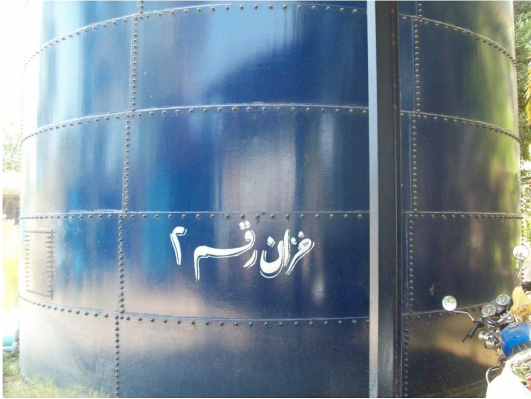
الخزان رقم ٢ للمياه المرشحة
