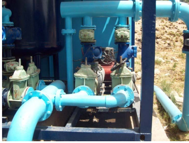
خزان الهيدروفورم وبجواره طلمبات الغسيل والضخ للشبكة
