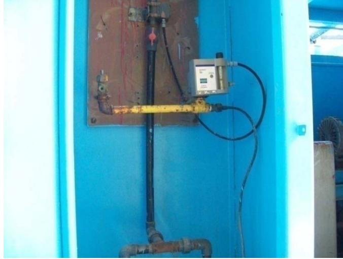
جهاز الكلور سعة ٢ كج
