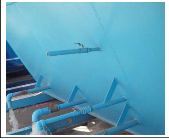
فتح محابس سحب الروبة في حاوية الترسيب النهائي
