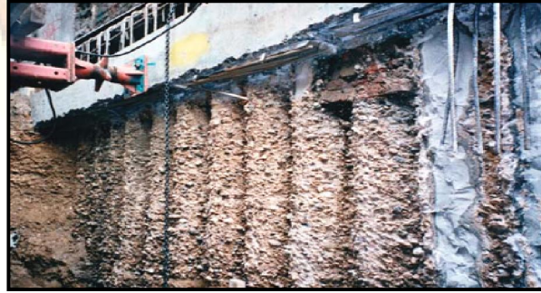
الشكل 8 صور توضيحية لتدعيم بناء قائم.
