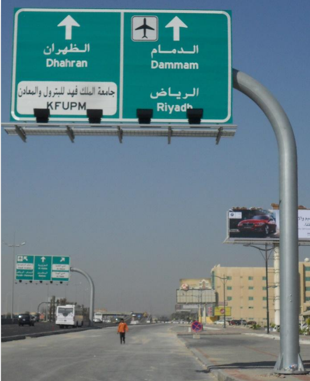
صورة (٢٠) G2-2 Cantilever Gantry
