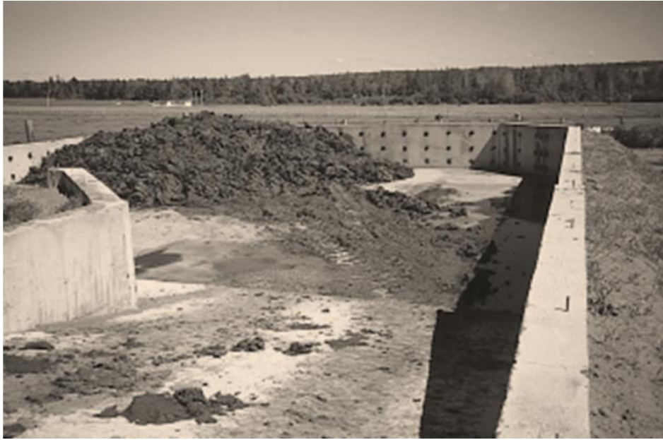
شكل يوضح مكان لتجميع المخلفات الصلبة وشبه الصلبة بأرضية خرسانية
