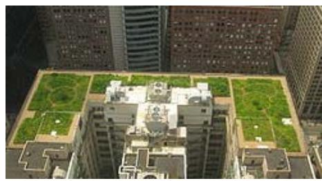
ومن عيوب زراعة الأسطح : وزنه على المبنى وكلفته الأولية و كلفة ربه و تصريف المياه و الصيانة و ولكن في المقابل فإنها تساعد على العزل الحراري و تقلل من الجزر الحرارية، وبذلك يمكن استخدام تحليل العوائد والتكلفة لتحديد الحاجة لاستخدام الأسطح الخضراء من عدمه.
