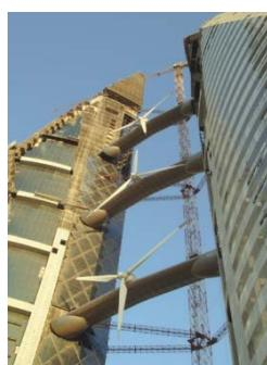
يمكن استخدام الرياح لتدوير التوربينات وتوليد الطاقة كما تم في تصميم مركز البحرين التجاري العالمي وذلك باستخدام ثلاثة توربينات. كما يمكن استخدام الطاقة المتعددة مثل الشمس والرياح والمولدات بالديزل العضوي والوقود الحيوي لتوليد الطاقة.
