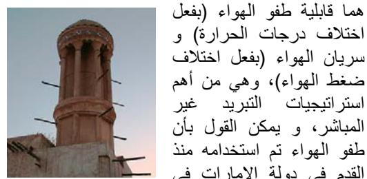
هما قابلية طفو الهواء (بفعل اختلاف درجات الحرارة) و سريان الهواء (بفعل اختلاف ضغط الهواء)، وهي من أهم استراتيجيات التبريد غير المباشر، و يمكن القول بأن طفو الهواء تم استخدامه منذ القدم في دولة الإمارات في البراجيل. واستخدام طفو الهواء في المباني مفيد في فصلي الصيف والشتاء وذلك نظراً لاختلاف درجات الحرارة داخل المبني و خارجه.
