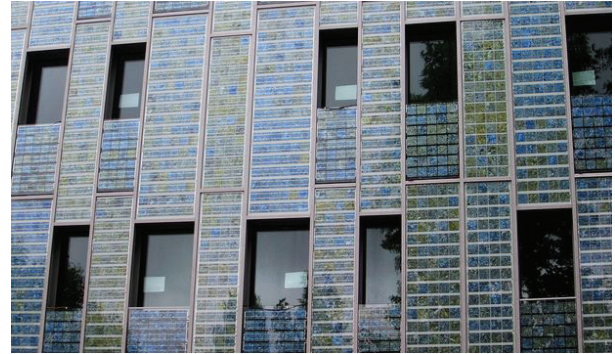
الشكل ٢٥: الألواح الكهروضوئية الملونة على واجهة إحدى المباني (www.flickr.com/photos/la-citta-vita/5964294206/).
