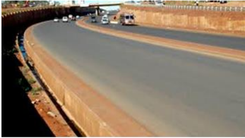
صرف مياه الفيضانات
