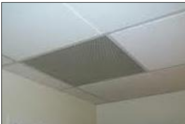
شكل (2- 6): سقف تخزين (Plenum).
