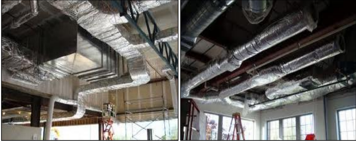
شكل (4-23): مجاري هوائية معزولة وحاجز البخار من الالمنيوم .
