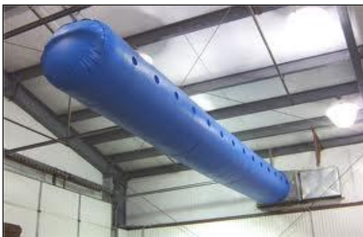
الشكل 3-7: مجري هواء من النسيج الصناعي.
